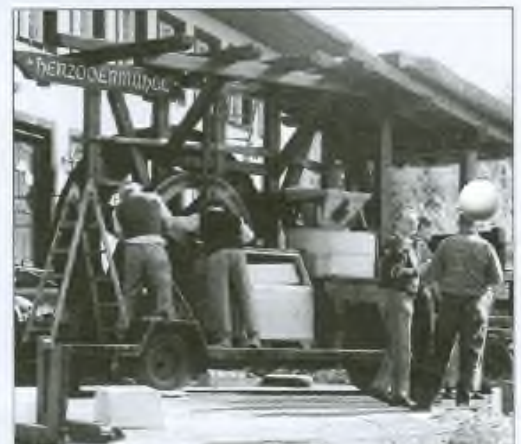
Zünftig am Arbeiten: Die «Herzogenmühle» wird für den Sechseläutenumzug gerüstet.
